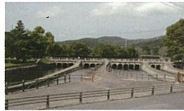
18 高梁川東西用水 取配水施設
